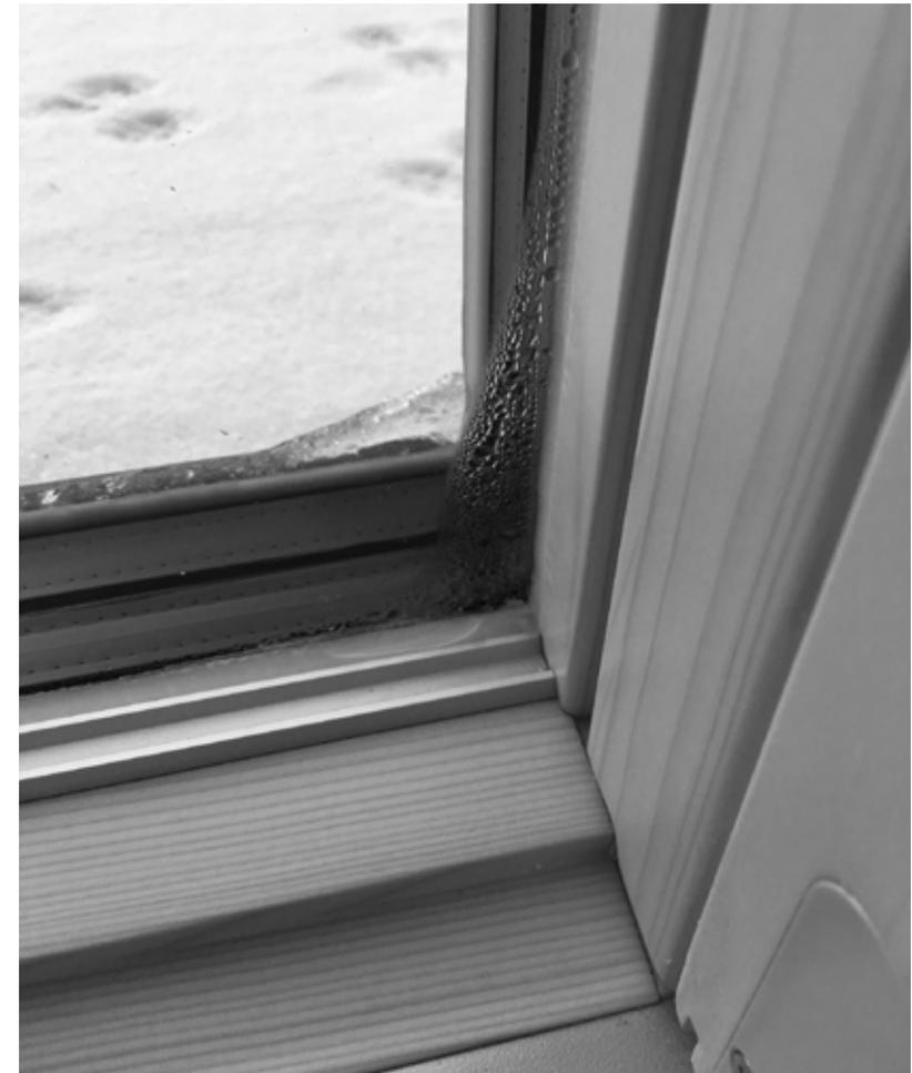
In der Abbildung zeigt sich deutliche Kondensatbildung auf der Innenscheibe im unteren Kämpferbereich einer Hebeschiebetüre. Ursache ist stehende, kühle Raumluft im unteren Eckbereich. Durch zu geringe Temperaturen im Schwellenbereich wird die Luftzirkulation vermindert. Kondensat kann entstehen und sich in Folge auch Schimmel bilden.
