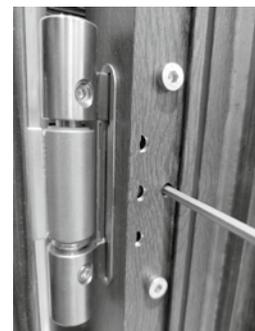
Anpressdruck so einstellen, dass die Dichtung keinen zu großen Druck im Bandbereich aufweist (Flügelüberschlag bei AT500, AT510 und AT520: 14 – 15 mm, bei AT530: 15 - 16 mm).
