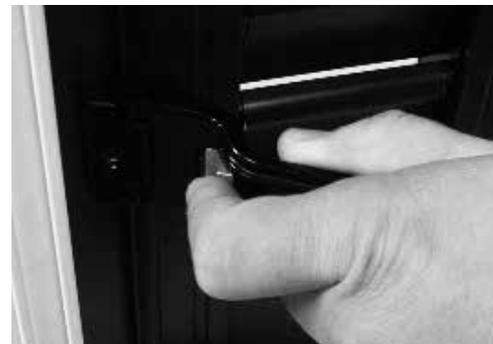
Beim **Schließen** des Ladens wird der Ladenhalter gedrückt und der Laden hereingedreht. Danach den Verschlusshebel drehen bis der Drehstangenverschluss selbsttätig einrastet.
