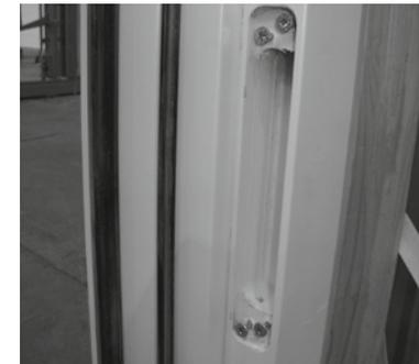
Bei ausgehängt geliefertem Flügel sind die Befestigungsschrauben im Rahmen eingedreht, diese sind zu entfernen.
