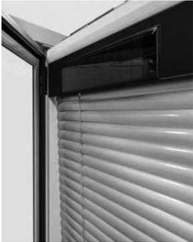
Zuerst Jalousie nach oben fahren! Fensterflügel mit Griff öffnen und Vorsatzflügel mittels Drehverbinder öffnen.
