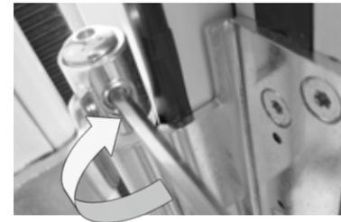
Anschließend von unten die Höhenverstellungsschraube mit Inbusschlüssel SW4 justieren.
