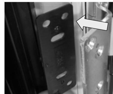
Anschließend Band am Flügel wieder festschrauben, Flügel wieder einhängen, Stift einschieben und Sicherheitsschraube wieder festziehen.
