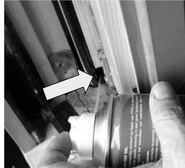
Den Lagerpunkt zwischen den Gleitflächen mit hochwertigem Schmierstoff (z. Bsp. Teflon-Öl) schmieren.
