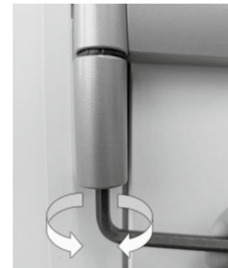
Heben und senken des Flügels mittels Inbusschlüssel SW6
