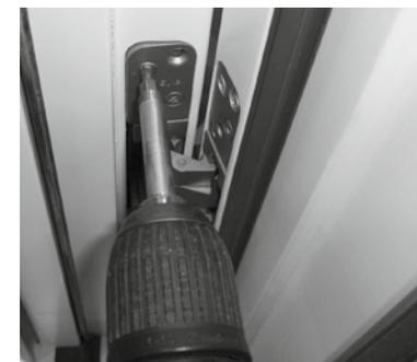
Bänder ohne verkanten in die Aufnahmetaschen gleiten lassen und jedes Band vorerst mit einer Fixierungsschraube positionieren.
