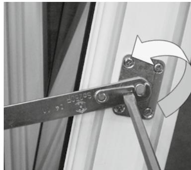
Verriegelung der Putzschere mit einem Flachschraubendreher öffnen und Putzschere aushängen.
