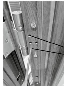
Beide Spannschrauben lösen.
