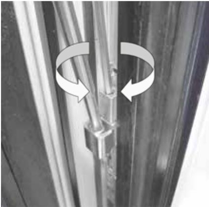
Anheben und Absenken des Flügels über die Flügellagerstange mit Inbusschlüssel SW4.
